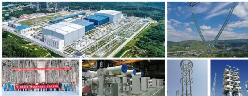
昆柳龙特高压多端柔性直流示范工程
