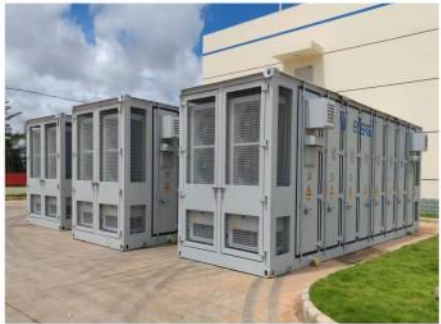
广东风电工程配套 12.2MW/12.2MWh储能项目
