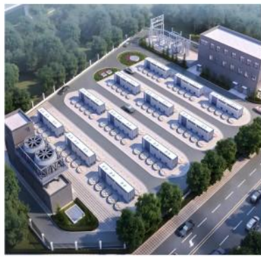
山西40MW/3MWh 混合储能
