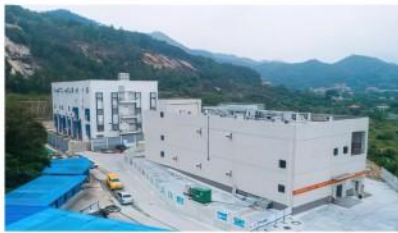
广东珠海紧凑型经济型直流配电项目
